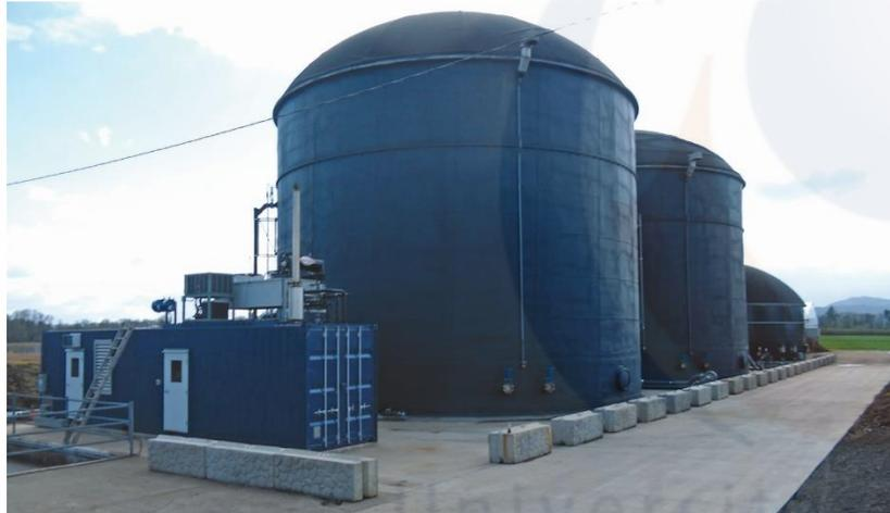
Gambar 17. Fermentor untuk reaksi anaerob (sumber: <https://www.biocycle.net/>).
